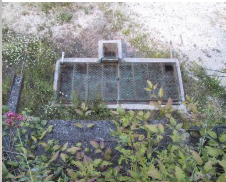
Grille de la ré injection des eaux des galeries de Silhol.
