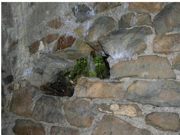
Trou dans le tunnel haut dans un secteur non encaissé. Partie basse débouchant dans regard d'accès.
