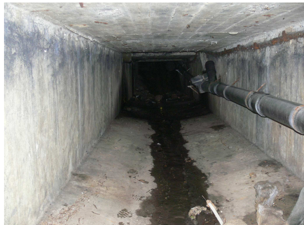
Partie bétonnée (192m.)
