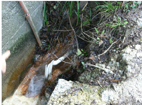
Détail du passage des eaux en bordure du mur du tunnel.
