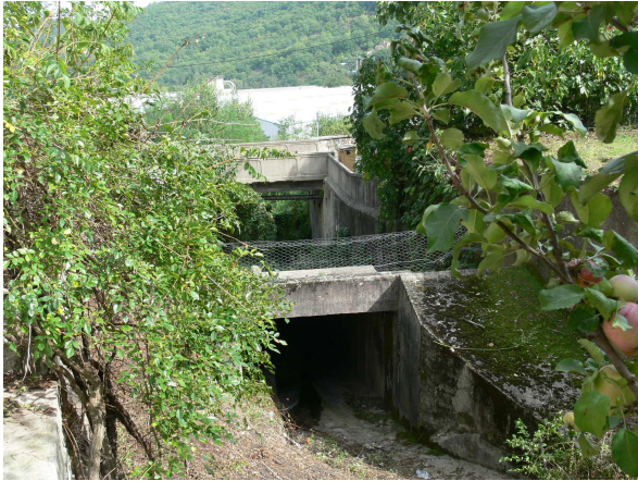
Débouché au jour (246m.)
