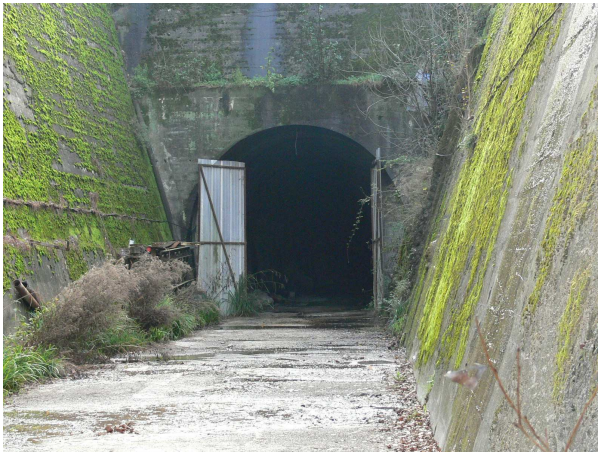
Ancien tunnel ferroviaire utilisé comme conduite.
