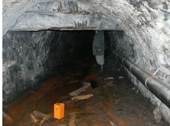
Fondation de l'usine (111m.)
