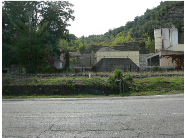
Passage de la buse sous la route et centrale à béton
