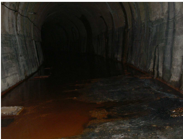
Fond du tunnel servant de réserve d'eau (ferrugineuse).
