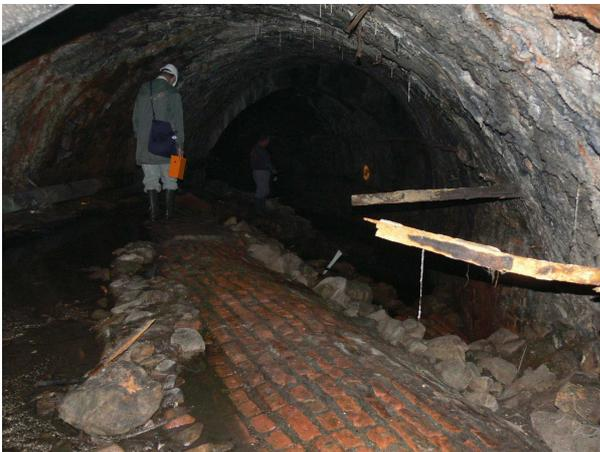
Seuil en brique, en biais dans le tunnel.
