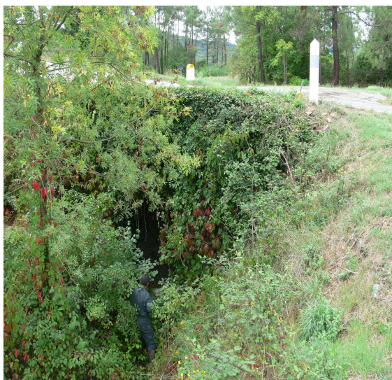
Entrée sud du tunnel, vue générale.
