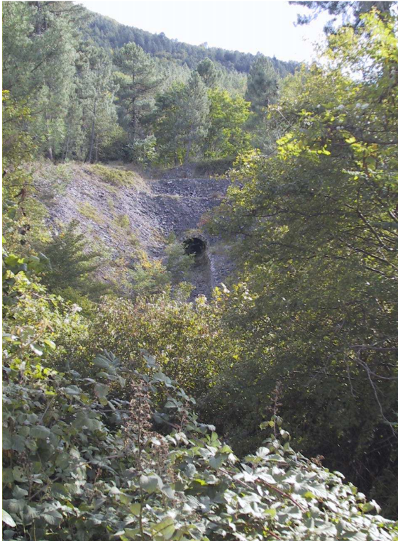
Tunnel Est : sortie nord du tunnel.
