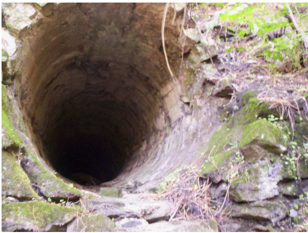
Sortie aval : aspect de l'intérieur du tunnel.
