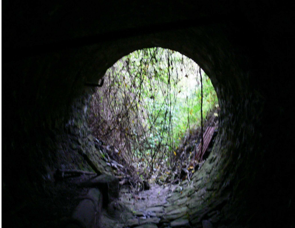
Sortie amont : vue intérieure.
