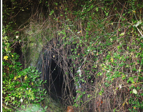
Sortie amont : vue extérieure.
