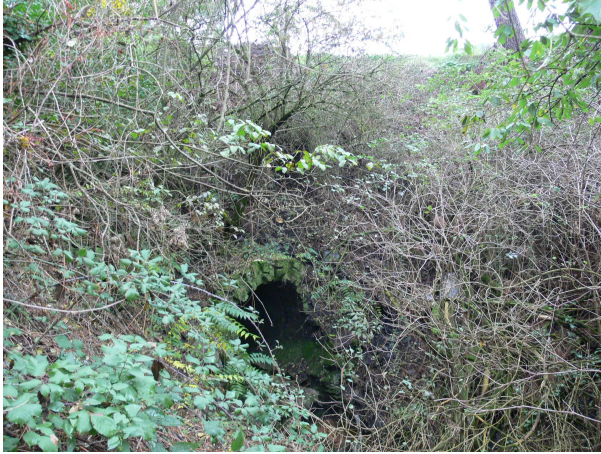
Tunnel Ouest : Sortie aval du tunnel dans le teruil.
